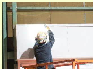
シャッター取付作業
