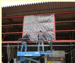
上部シート貼り付け
