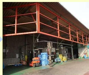
鉄骨の取り付け
