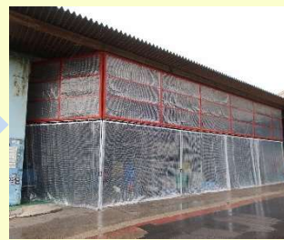
下部カーテンシート取付
