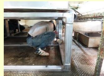
架台のボルト止め
