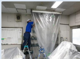
内機高圧洗浄
