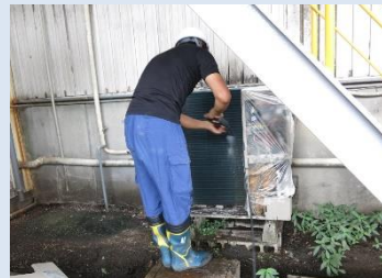
外機高圧洗浄
