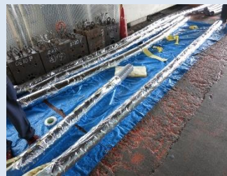
保温ダクト製作
