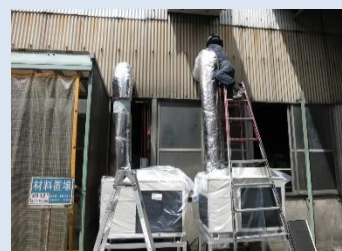
外ダクト保温・施工完了
