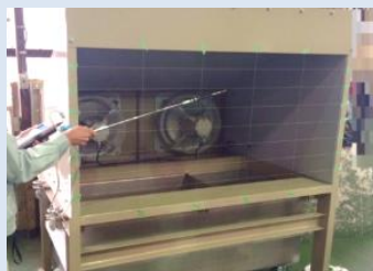
集塵機の風量測定
