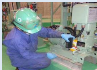
設備機械の振動測定
