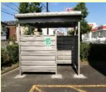
施工事例①
