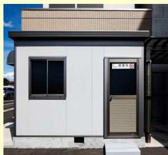
施工事例②
