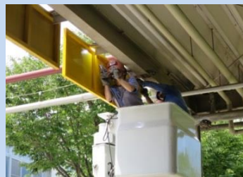
③ 溶接作業
