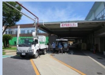
① 工事施工前
