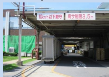
④ 工事施工後
