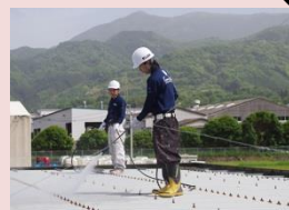
①高圧洗浄 下地に付着している埃・汚れを洗い流す。
