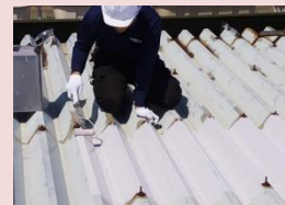
③下塗り 表面のサビに優れた保護性能を発揮し仕上げ材との接着を良くする。
