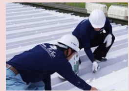
④上塗り 屋根全体をコーティング。塩害、紫外線等から長期間保護する。
