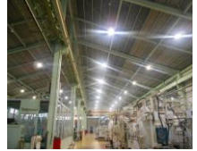
③施工完了後
