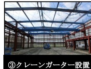
③クレーンガーター設置
