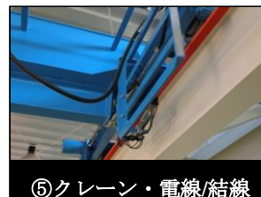
⑤クレーン・電線/結線
