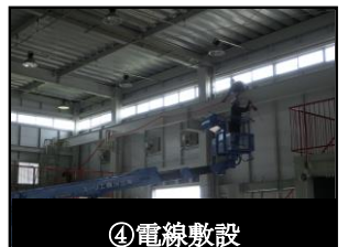
④電線敷設
