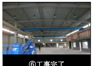
⑥工事完了
