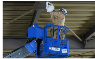
高所作業車による設置・交換
