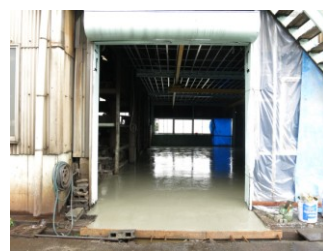
⑥施工完了
