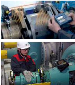
レーザー芯出しの例
