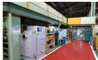
③据付完了
