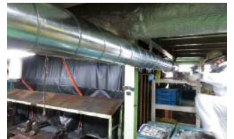
④据付後のダクト工事
