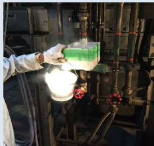
⑤配管凍結後、液体窒素を抜いています
