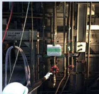
③凍結用発砲スチロール設置
