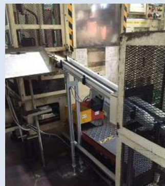
④据付完了・利用説明
