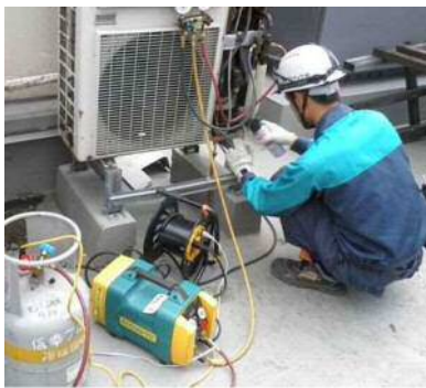
定期点検の様子
