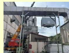
クーリングタワー据付中
