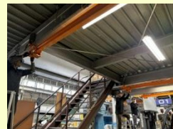
走行レール取付
