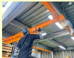
伸縮レール取付
