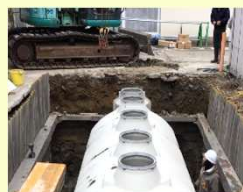
浄化槽据付け
