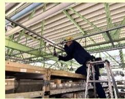
蛍光灯取外し
