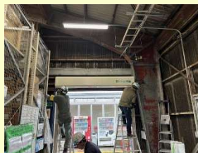
ボックス設置
