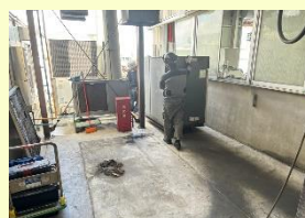
既設品の撤去
