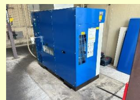
新規品の据付け
