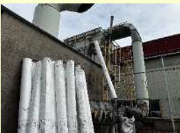
ろ布交換・取付け
