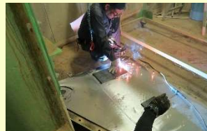
当て板溶接作業
