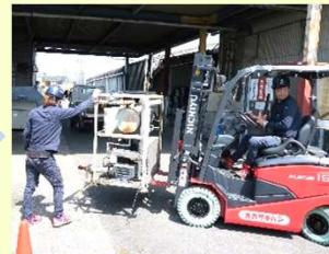
既設チラーの撤去
