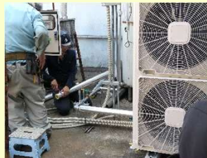
新規チラーの設置
