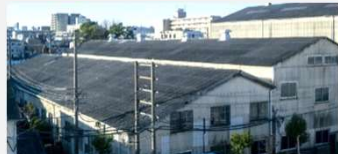
高所の外観検査
