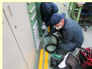
飛び出し防止プレート設置
