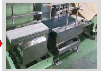
↑ ⑥工事完了
