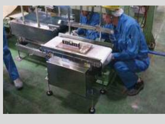
↑ ③据付調整
