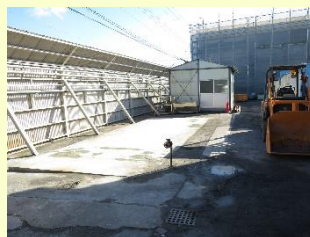
解体・撤去完了
