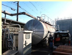
解体・撤去前
