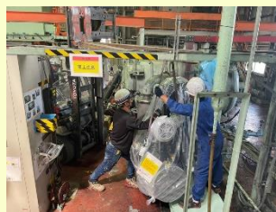
新規ポンプ設置
