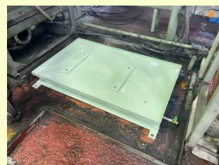
新規架台設置
