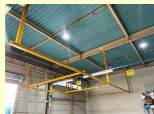
走行用レール取付
