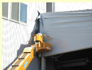
コーキング施工
