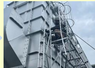
取り外し作業
