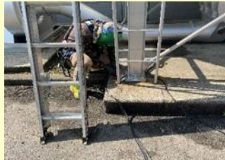
取り付け作業
