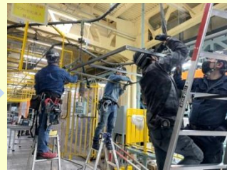
吊りブラケット設置
