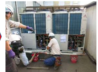
↑④室外機設置
