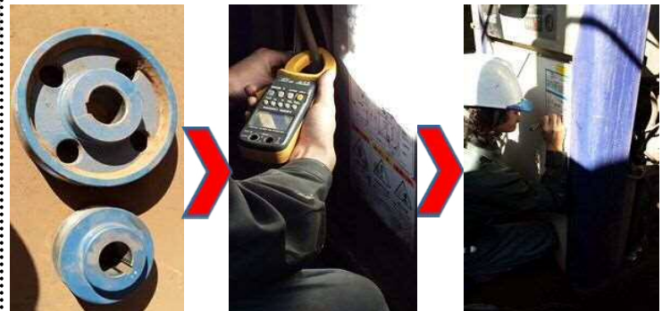
↑③外したVプーリー ↑④試運転、電流値確認 ↑⑤点検内容記入
