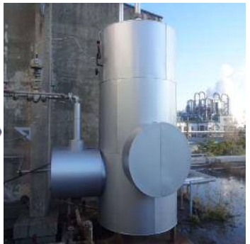
↑④メンテナンス・工事完了
