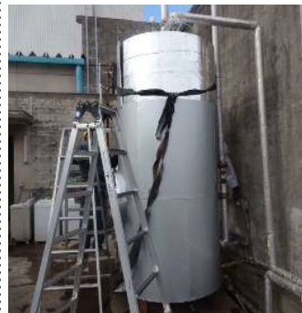
↑③断熱材の上からブリキ取り付け
