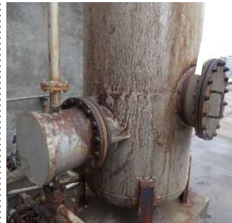
↑①古い断熱材を剥がす
