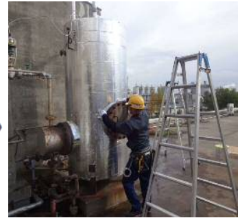
↑②断熱材取り付け
