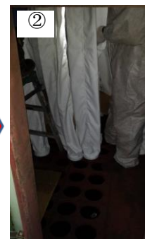
濾布取付作業
