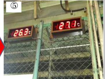
⑤ 水量が増えて冷却水の温度が正常化。冷却水の温度も26.3度、27.1度に下降した。
