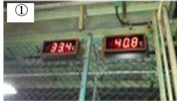
① 配管が詰まり冷却水の温度が上昇。温度計はそれぞれ 33.4度、40.8度を示している。
