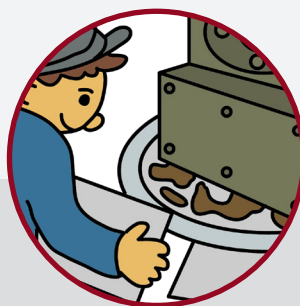
機械周辺の油の吸い取り
