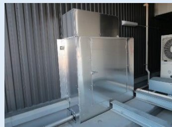
④施工完成
