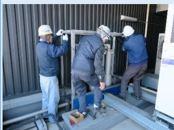
①ベース組み上げ作業
