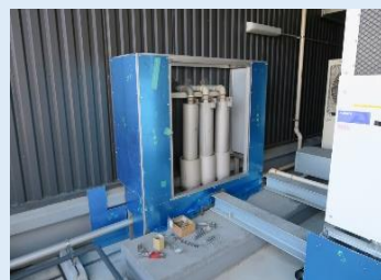
②防音壁組み込み作業
